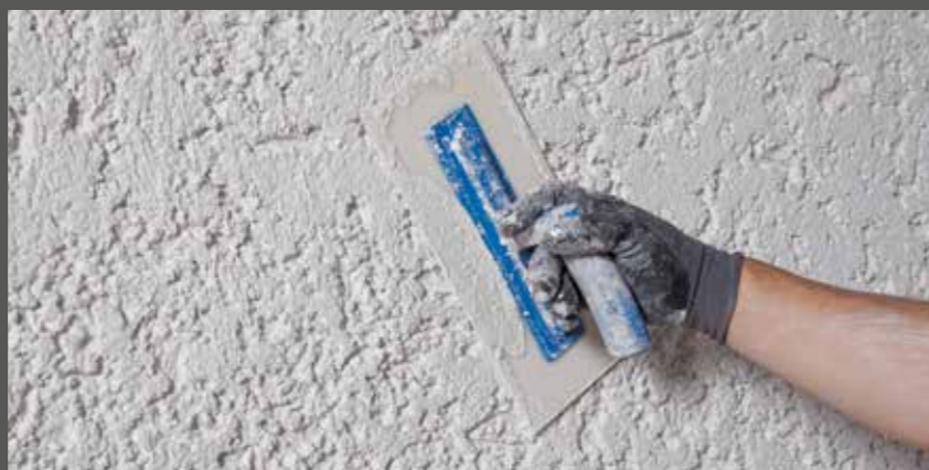
Varijanta: RÖFIX 750 krupnozrnati završno-dekorativni malter se nakon nanošenja zaribava
