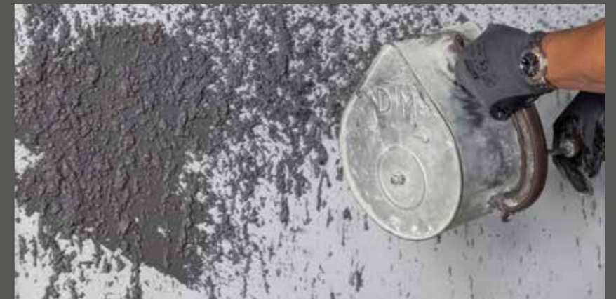
Varijanta: Izvođenje tehnike špricanja aparatom za špricani malter (tzv. hirofom)
