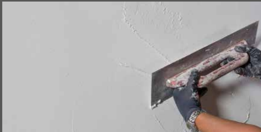
Nanošenje RÖFIX ljepila i mase za armiranje
