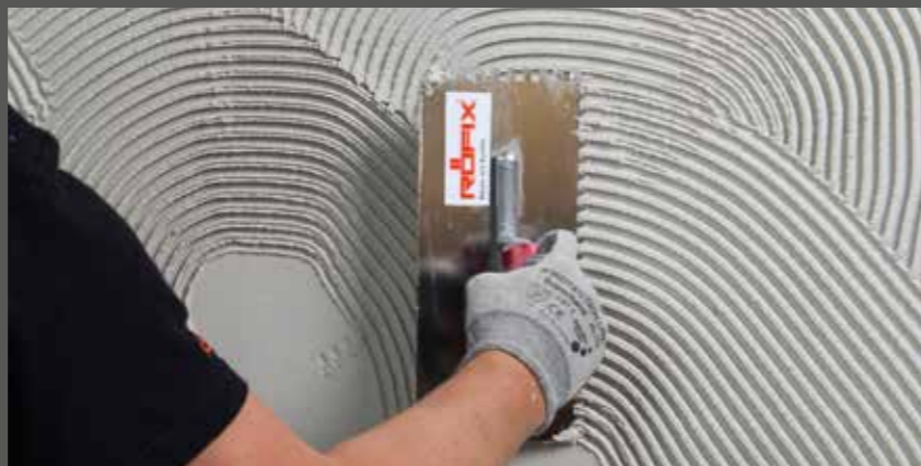
Pročešljati RÖFIX ljepilo i masu za armiranje
