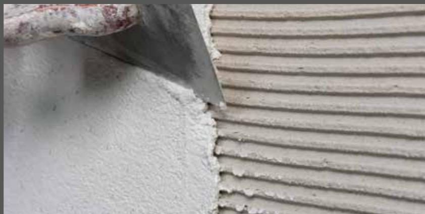
RÖFIX 772 šerani malter se nanosi na prethodno pročešljano (zupčastim gleterom) RÖFIX ljepilo i masu za armiranje
