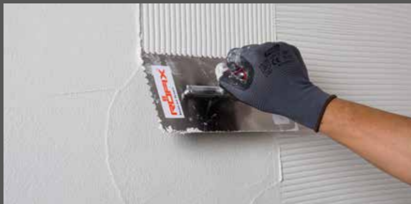
Površinu pročešljati RÖFIX S6 gleterom za izbijanje mjehurića zraka
