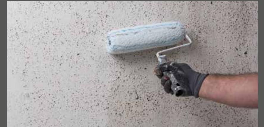
Grundiranje i zaštita RÖFIX PP 403 MULTI silikonskim premazom
