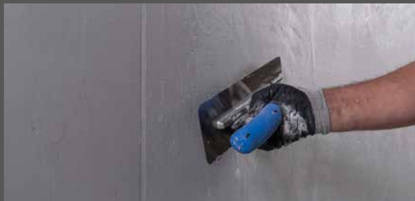
Nanošenje sljedećeg sloja RÖFIX Anticofino®
