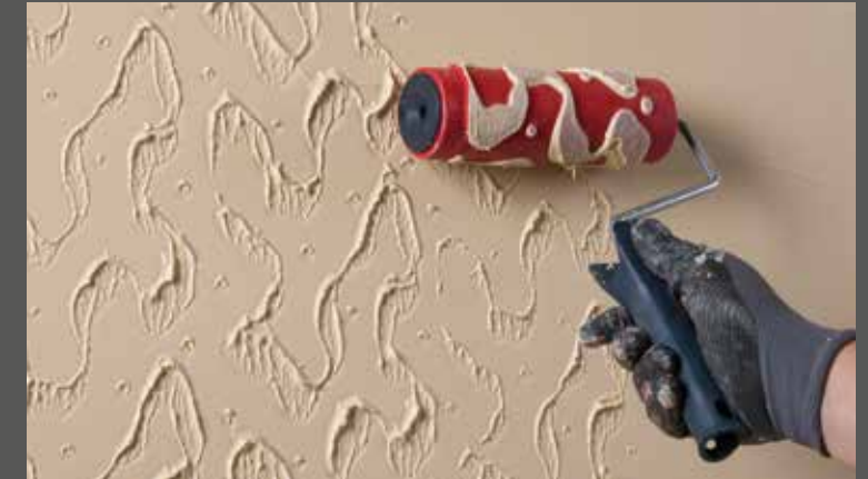
Strukturiranje RÖFIX Decofino maltera valjkom za strukturiranje
