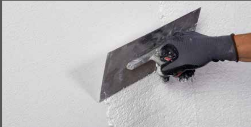
Grundiranje i nanošenje završnog maltera
