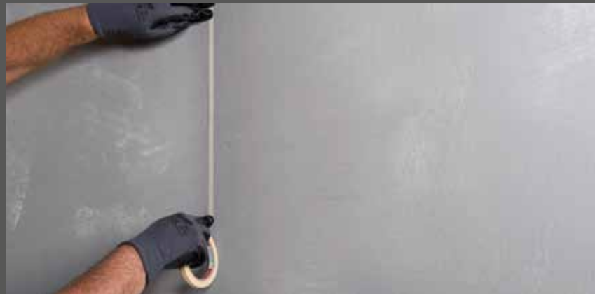
Umetanje ljepljive trake
