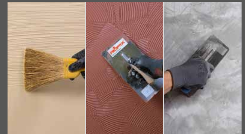
Strukturiranje RÖFIX Decofino maltera metlom
