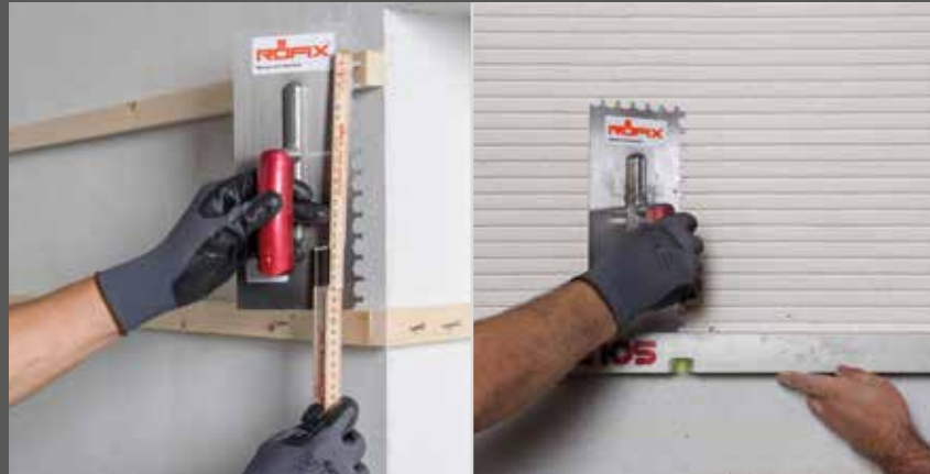
Montaža letve za ravno češljanje ili korištenje libele (slika desno)
