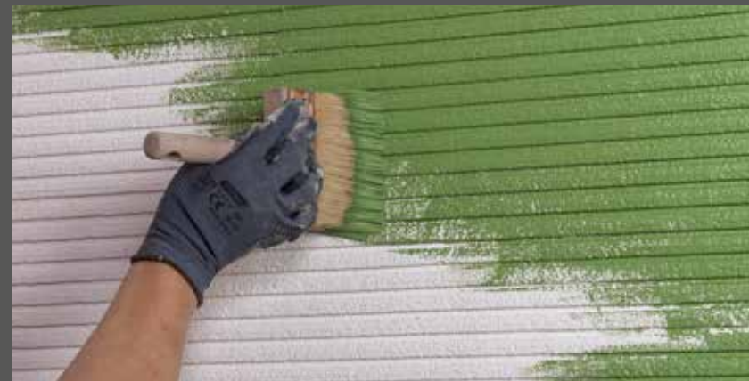
Začešljanu površinu grundirati i dva puta premazati bojom
