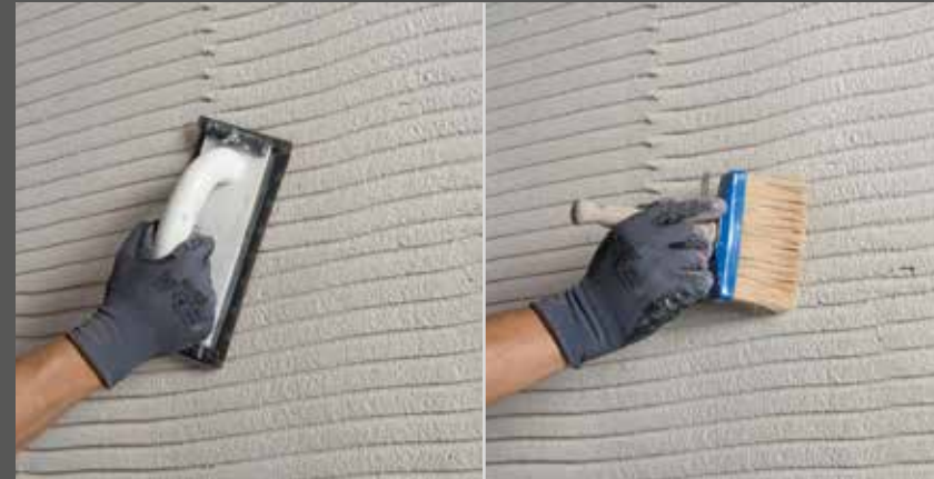
Vrhove sučelnih spojeva maltera obrusiti i otprašiti
