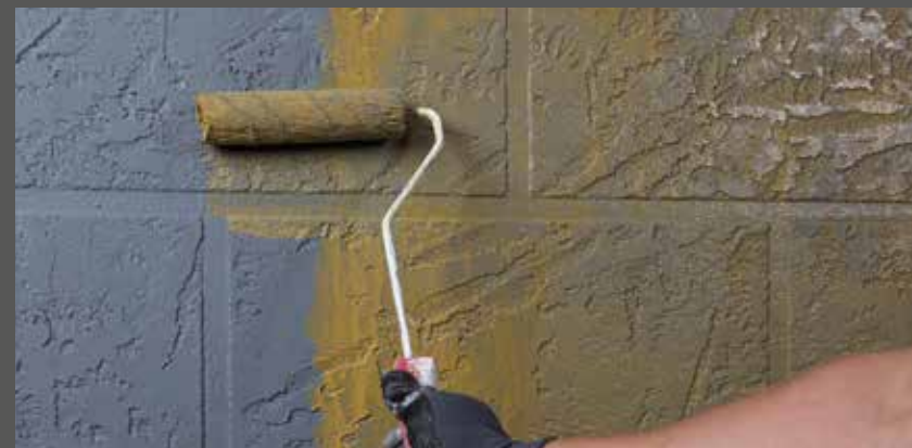
Premazivanje RÖFIX PP 403 MULTI silikonskim premazom/lazurom
