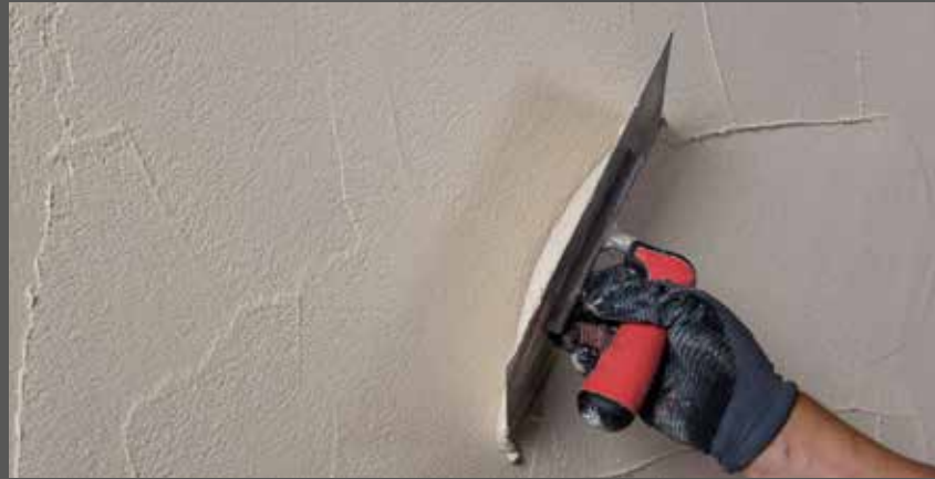
Nanošenje završnog maltera
