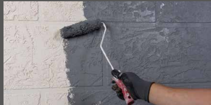
Temeljni premaz RÖFIX PE 519 PREMIUM SISI fasadnom bojom
