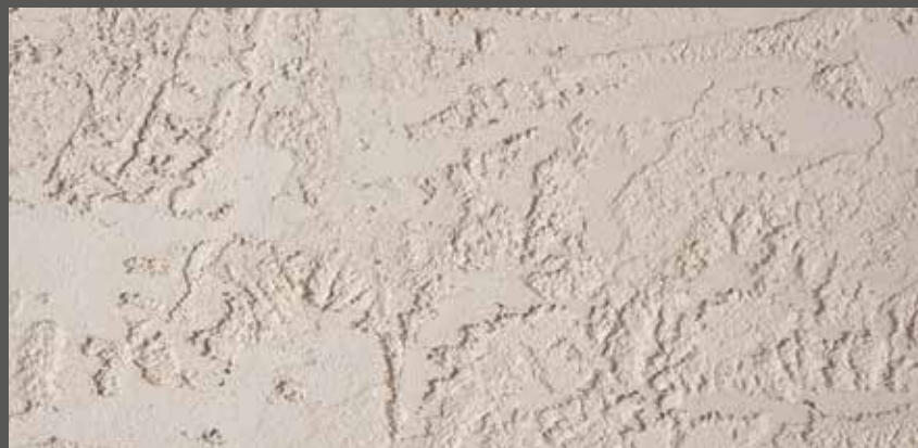
Grundiranje i bojanje suhog završno-dekorativnog maltera
