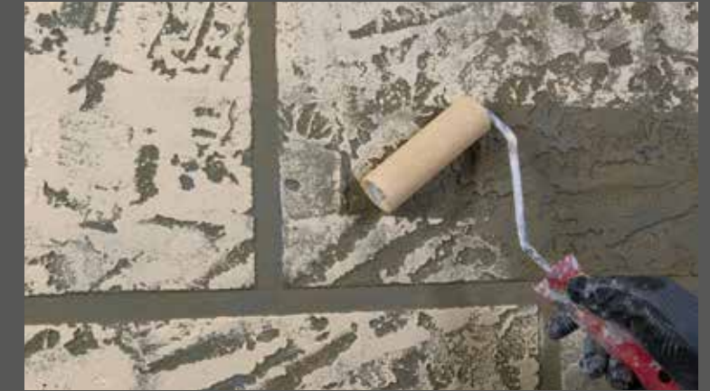
RÖFIX PE 519 PREMIUM SISI fasadna boja nanosi se spužvastim valjkom
