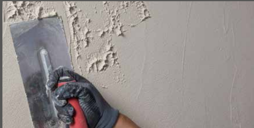
Tapkanje/pritiskanje svježe nanesenog završno-dekorativnog maltera
