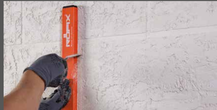
Naknadna obrada lopaticom za oblikovanje
