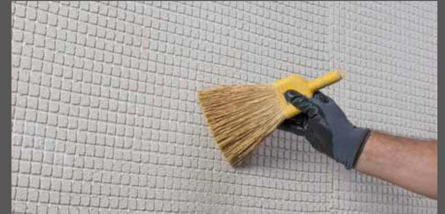
Čišćenje površine metlom
