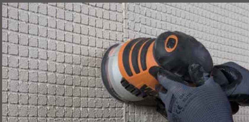
Brušenje suhe površine
