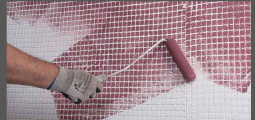
Vrhove pažljivo premazati spužvastim valjkom
