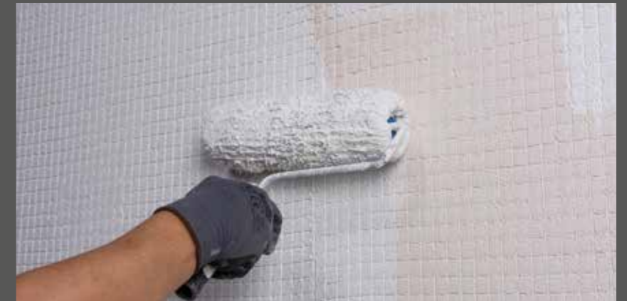
Grundiranje i premazivanje
