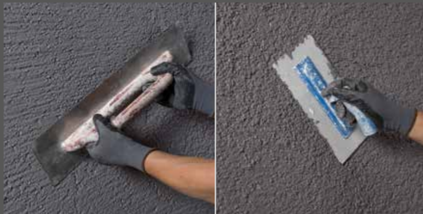
Nanošenje RÖFIX SiSi-maltera® VITAL i strukturisanje
