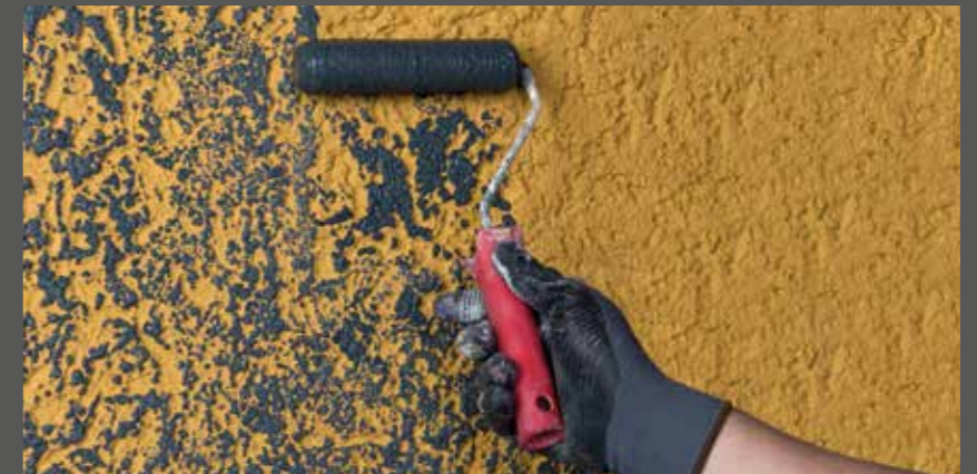
Grubi strukturni završni malter poravnate/nabijene površine „špicevima“ i premazan drugim tonom boje
