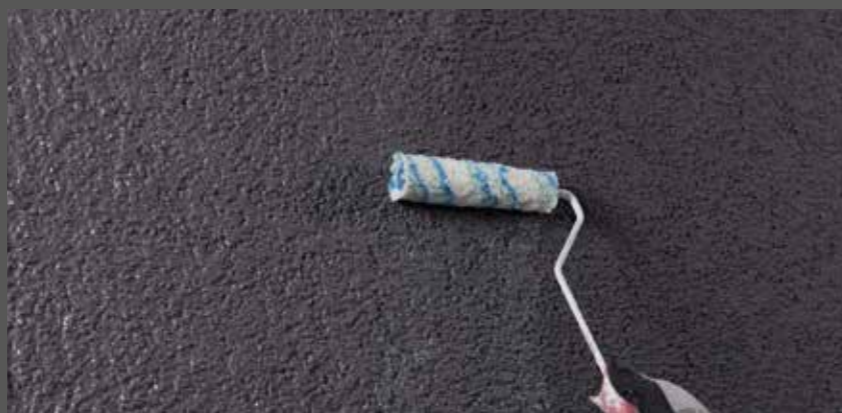
Obojani RÖFIX strukturni završni malter premazan RÖFIX PP 403 MULTI silikonskim premazom sa RÖFIX SILVERGLOW-om
